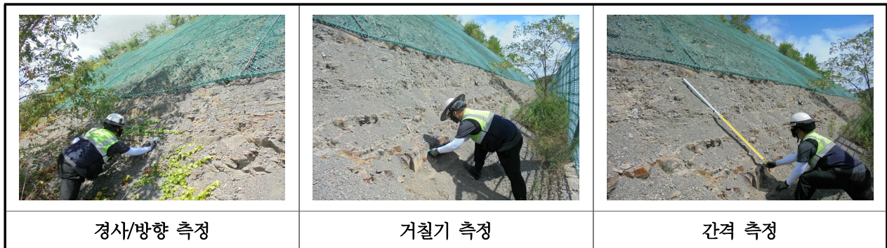
【사진 66.3.3】 불연속면 측정 현황
